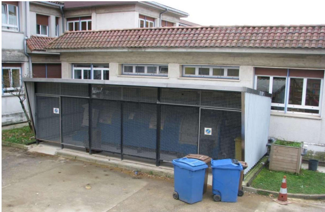
Joonis 11 Väikereaktor, mis teenindab koolisööklat Hispaanias. Näha on ka pruunid konteinerid toidujäätmete toomiseks, haisubiofilter (laudisega) ning järelvalmimiskamber (suurte luukidega sektsioon)
