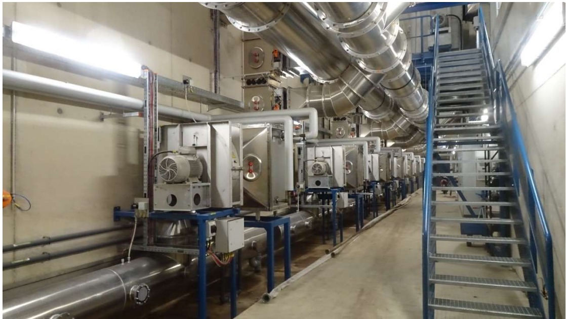
Joonis 16 Tunnel-kompostimisreaktori teenindusseadmestik. Soojusvaheti on kahepoolne, võimaldades küttevõrku juhtida kompostimise lisasoojust
