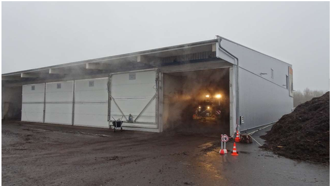
Joonis 15 Tunnel-kompostimisreaktor Saksamaal (20 000 t/a)
